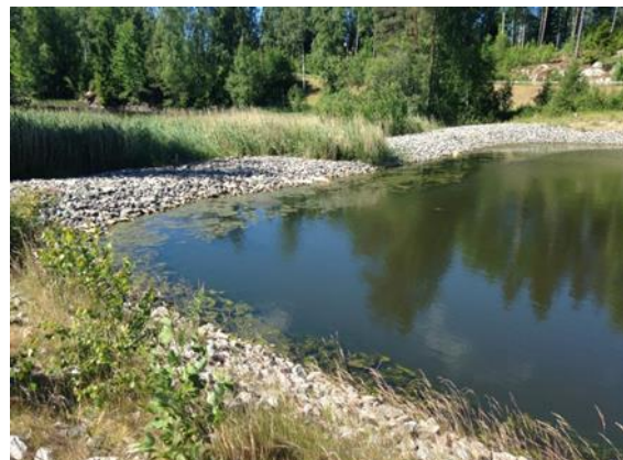
Dagvattendamm. Foto: Camilla Högdahl Bergström
